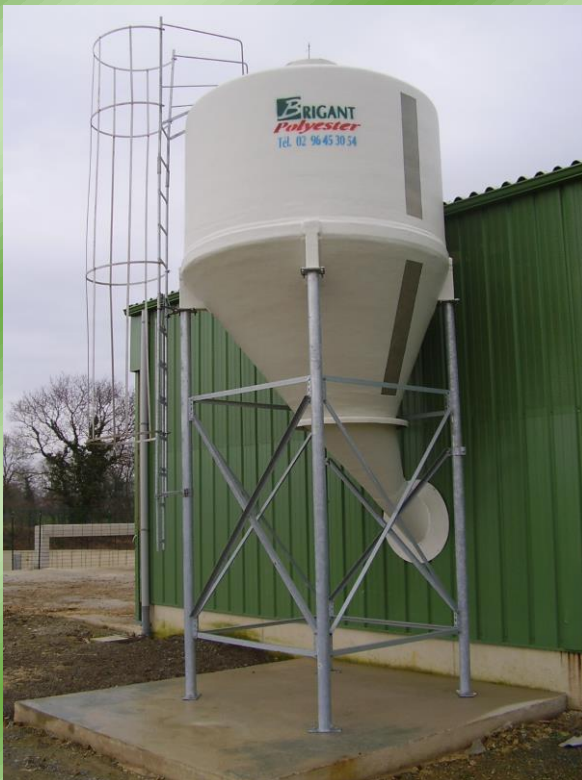
Silo avec goulotte pour vidange intérieure dans un chariot
